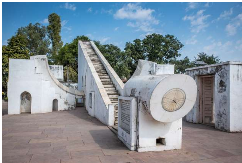
Один из инструментов обсерватории в Уджайне – Самрат-Янтра (главный инструмент). Наклонная лестница направлена параллельно полярной оси строго на север. По краям от лестницы полукруглые шкалы, выполняющие функцию солнечных часов. Еще одни солнечные часы с гномоном видны в виде круглой плоскости справа.
